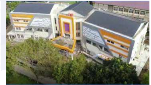
Pembangunan Gedung Kuliah Terpadu TIK Politeknik Negeri LHokseumawe, Aceh (2022)
