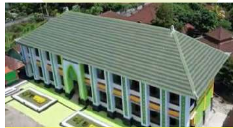
Ruang Kelas MTsN Karangasem, Bali (2021)
