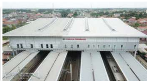
Pembangunan Fasilitas Perkeretaapian Bekasi s.d Cikarang, Jawa barat (2019-2022)
